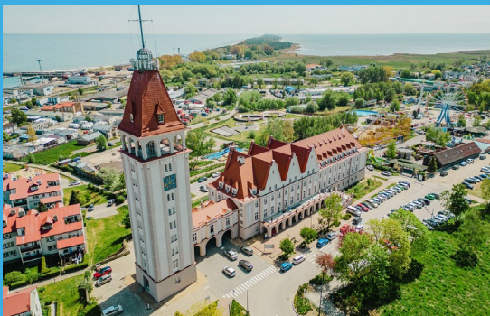
Przebudowa wieży Ratusza Miejskiego we Władysławowie w zakresie remontu klatki schodowej, wymiany windy, urządzenia toalety publicznej oraz remontu pomieszczeń na czterech kondygnacjach
