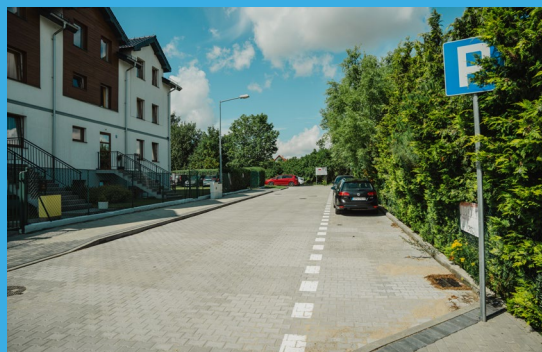
Przebudowa drogi gminnej ulicy Fenikowskiego we Władysławowie
