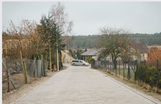
Budowa ul. Gryfa Pomorskiego w Tupadłach
