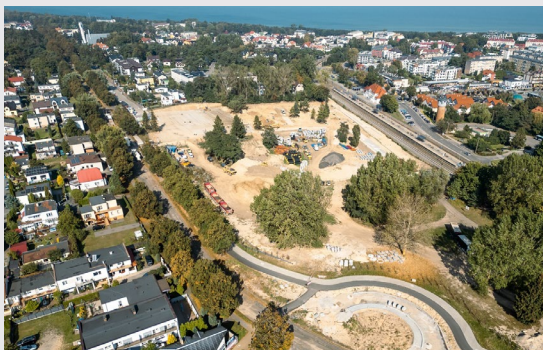
Budowa węzłów integracyjnych Władysławowo i Jastarnia wraz z trasami dojazdowymi - roboty budowlane w trakcie realizacji
