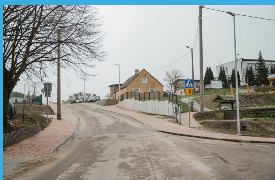
Budowa ul. Szkolnej w Tupadłach
