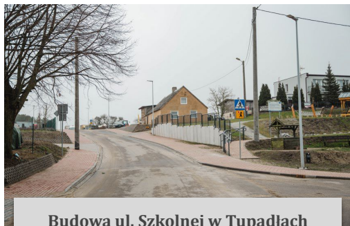
Budowa ul. Szkolnej w Tupadlach
