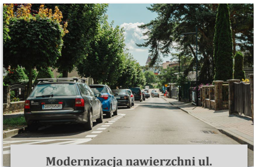
Modernizacja nawierzchni ul. Obróńców Helu we Władysławowie
