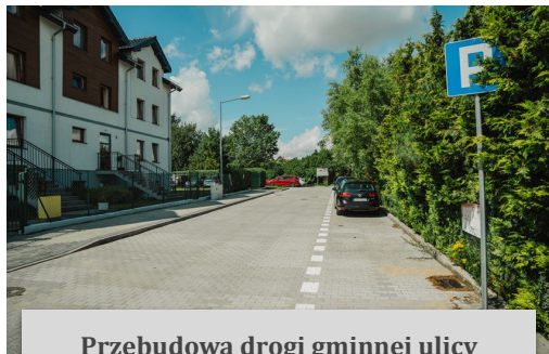
Przebudowa drogi gminnej ulicy Fenikowskiego we Władysławowie
